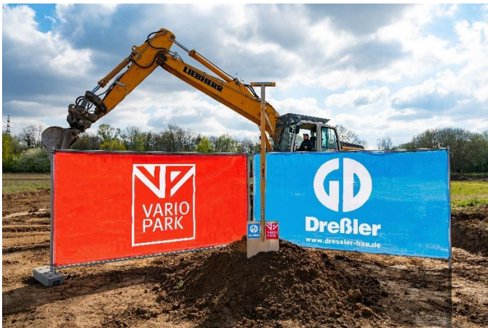
Einsamer Spatenstich für den VarioPark Bensheim, Bruchwiese 4 (Fotos: VarioPark)
